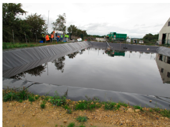
Figure 2. Source liquide correspondant au bassin de retenue des lixiviats de la plate-forme.
