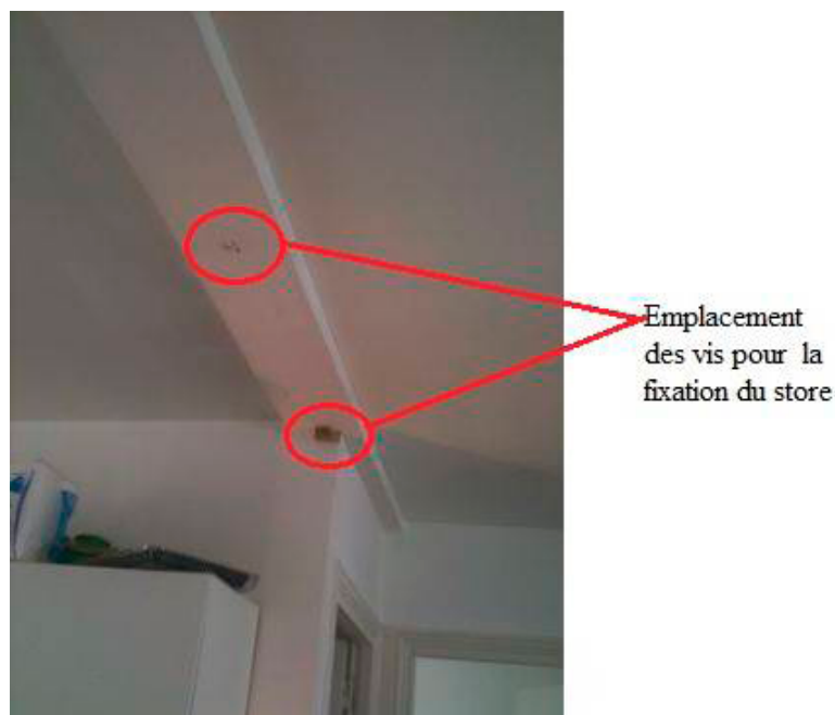
Figure 7. Vue du faux plafond du logement situé au-dessous. View of the ceiling of downstairs flat.
