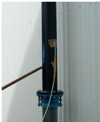
Figure 4. Point de prélèvement sur gaine d'air vicié extrait d'une vasque digesteur.
