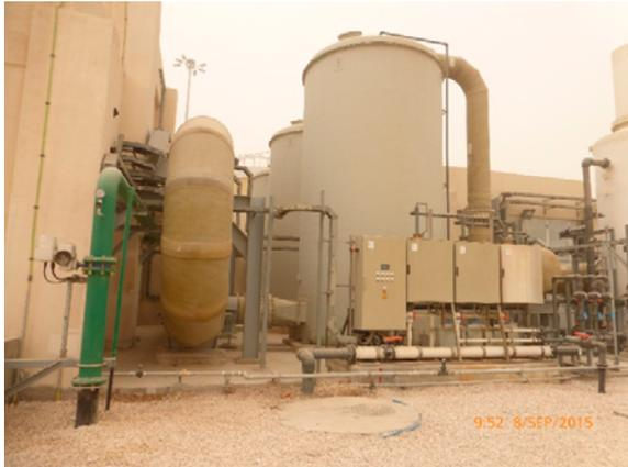
**Figure 11. Biofiltre ruisselant traitant les flux en H<sub>2</sub>S sur As Samra.**
